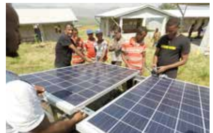
Montage der PV-Module
