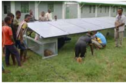
Solaranlage in Ayila
