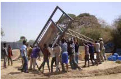
Gute Handwerker beim Aufbau
