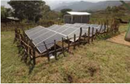
5 KW-Anlage, Montage Sep. 16
